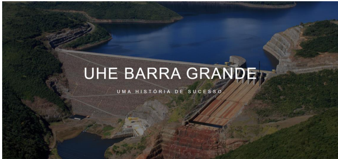
Figura 5 – Barramento, Vertedor, Casa de Força da UHE Barra Grande – Foto do site da Baesa – Baesa Energetica S.A. ( https://www.baesa.com.br/ ).
