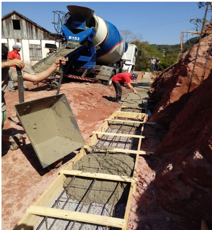
Exemplo de concretagem de base de Muros.
