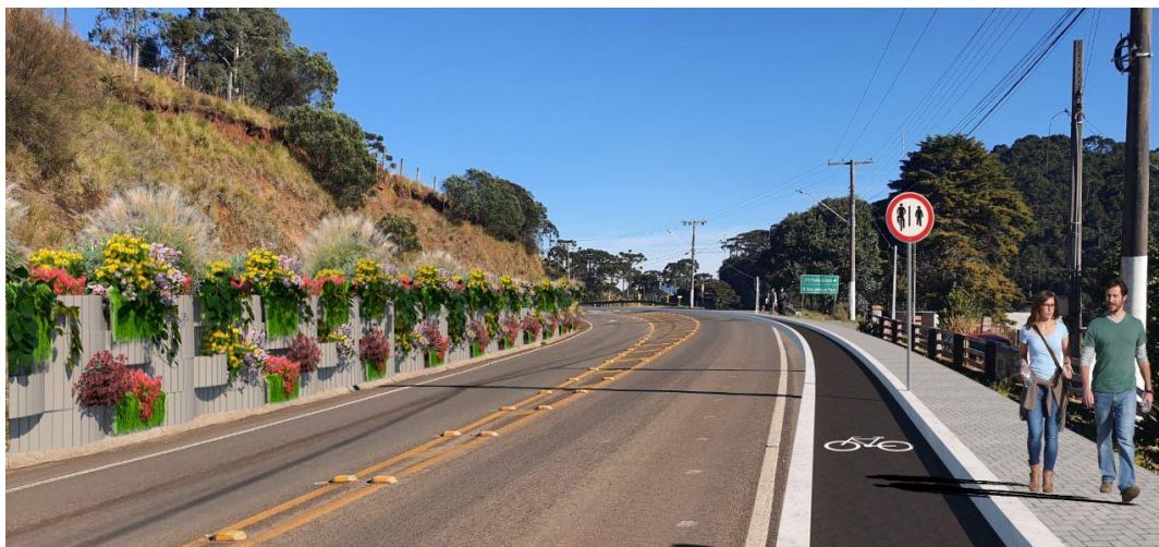
Perspectiva de muro com blocos e escadaria.
