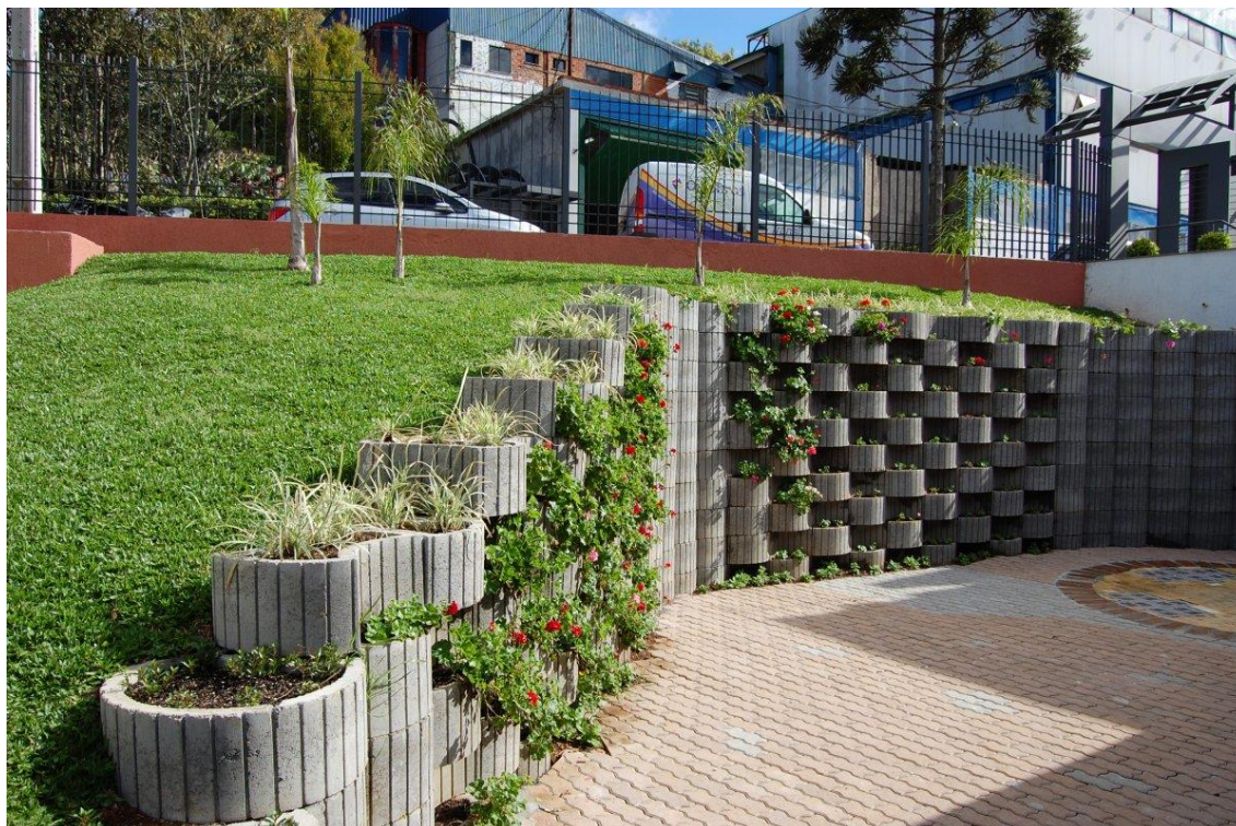
Exemplo de Muro de contenção com blocos tipo floreiras.
