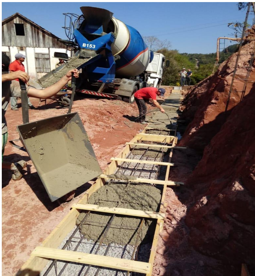
Exemplo de concretagem de base de Muros.
