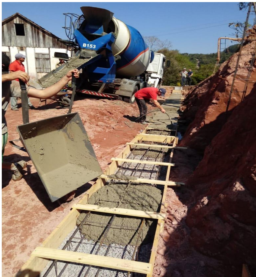
Exemplo de concretagem de base de Muros.
