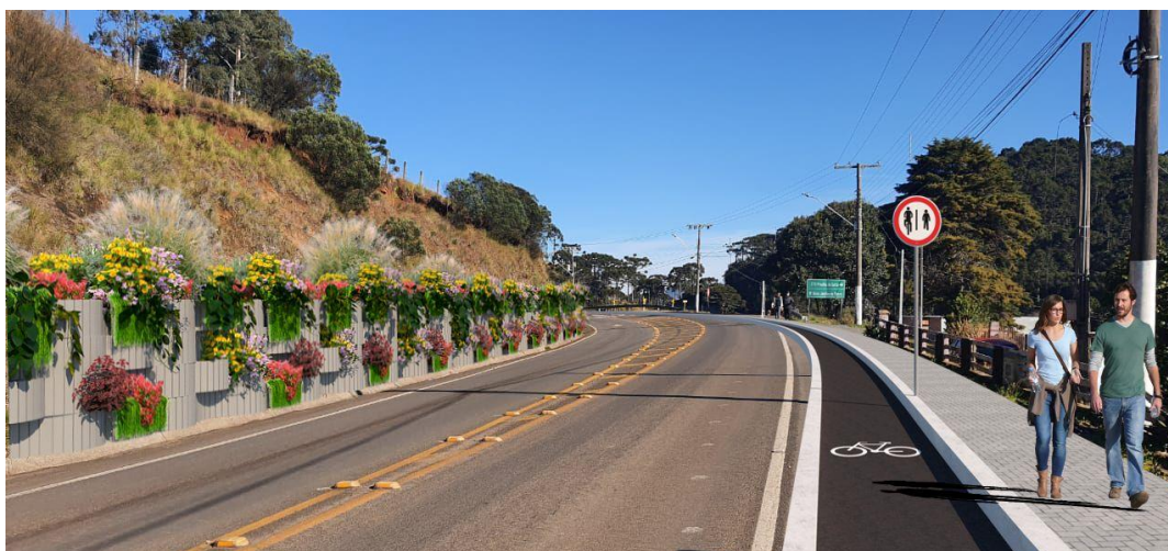
Perspectiva de muro com blocos e escadaria.
